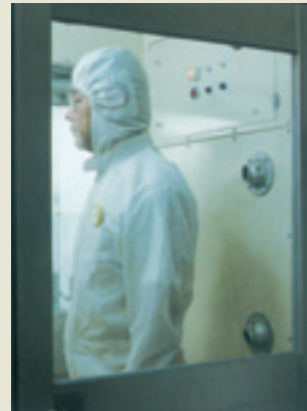
●エアシャワー室
